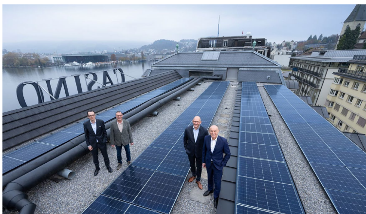
v.l.n.r.: Roman Baselgia (CFO), Marcel Menet (Leiter Technischer Dienst), György Bodnar (Nachhaltigkeitsbeauftragter) und Wolfgang Bliem (CEO) bei der neuen Photovoltaikanlage des Grand Casinos Luzern.
